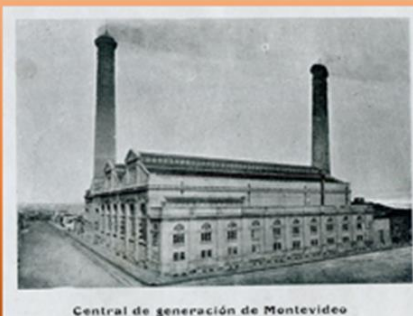
Central de generación de Montevideo
